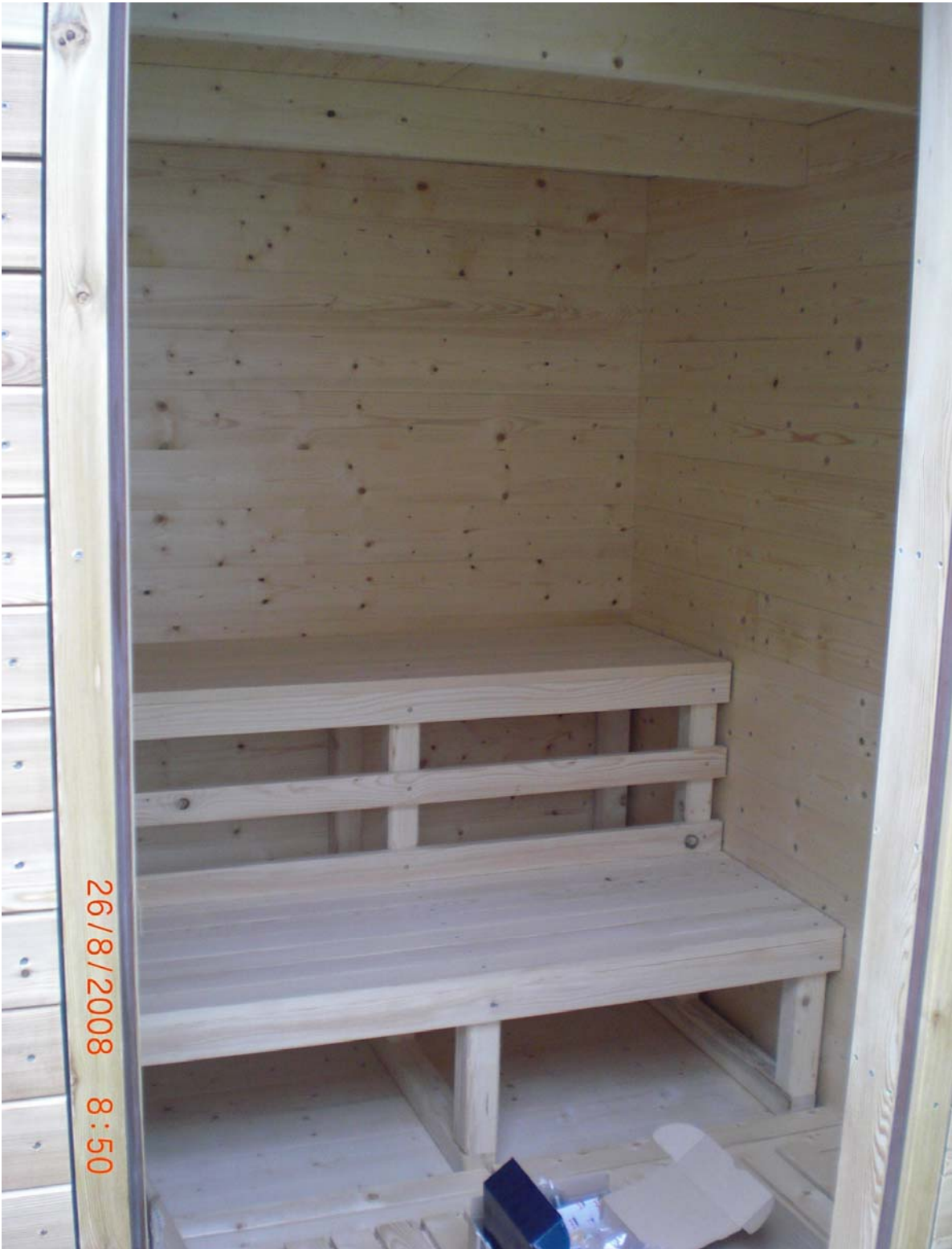
Innenansicht der Sauna (Gitterrost und Bank aus feiwüchsiger Tanne)
